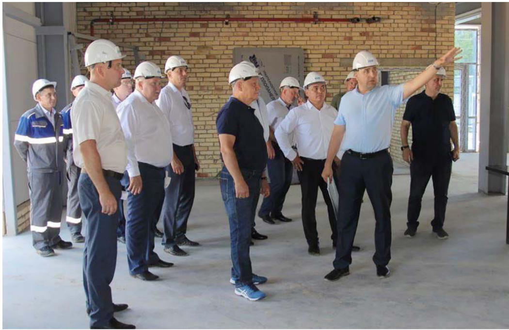
Автотранспортное хозяйство Аркауловского ЛПУМГ строится в соответствии с современными стандартами ПАО «Газпром»
